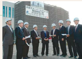
スパコン建設現場を視察
